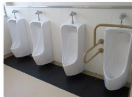
トイレ新設工事
