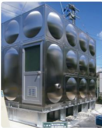
給水ステンレスタンク新設工事
